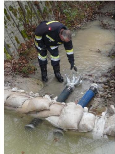
wurden mit unterschiedlichsten Mitteln (Leitern, Druckschläuchen, Saugschläuchen und Sandsäcken) Ölsperren auf verschiedenen großen fließenden Gewässern errichtet.
